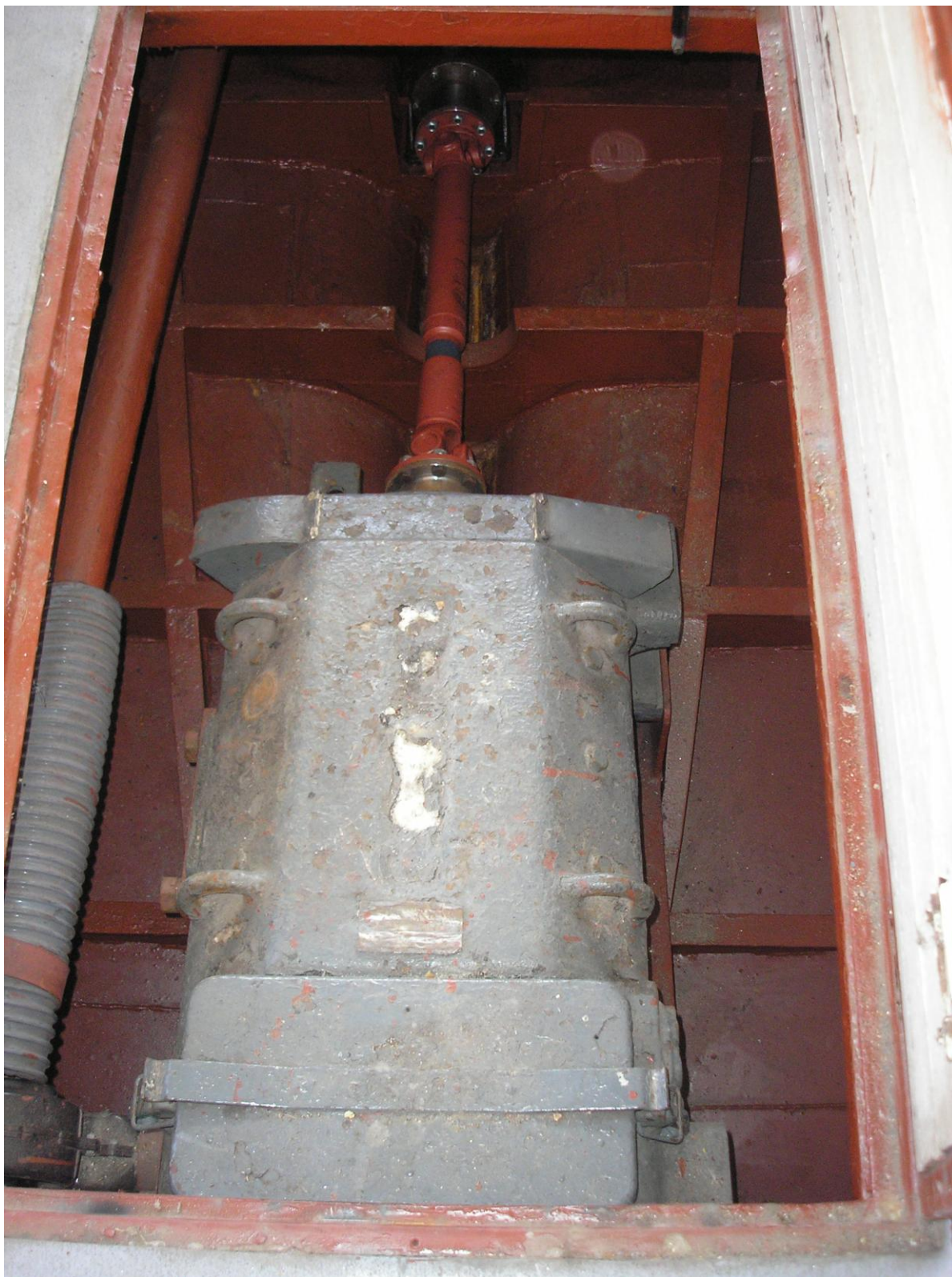
Obr. 11 Hnací elektromotor a hřídelové vedení
